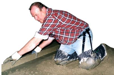
Beinschutz mit eingelegten Kniepolstern, die jede Bewegung zulassen. Das Material ist absolut wasserfest und für extrem hohen Abrieb ausgerüstet. Die Chaps sind nahtfrei gearbeitet, sodass keine Estrichbrühe nach innen dringen kann. 1 Größe für alle durch verstellbare Länge und Befestigung mit Chapklammern am Gürtel oder Hosenbund mittels elastischen Bändern. Reicht vorne 3 handbreit bis oberhalb des Knies. Zertifiziert nach DIN EN 14404.
